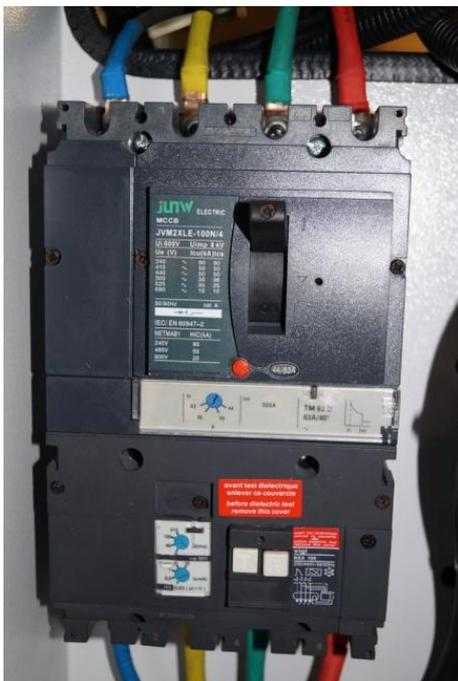
Les groupes électrogènes GELEC sont équipés d'un disjoncteur tétrapolaire qui intègre une protection magnéto-thermique et une protection différentielle réglable.
